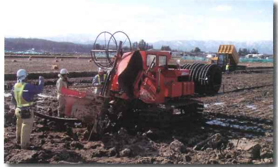
宮地地区 地下かんがい施設幹線パイプ埋設工事
