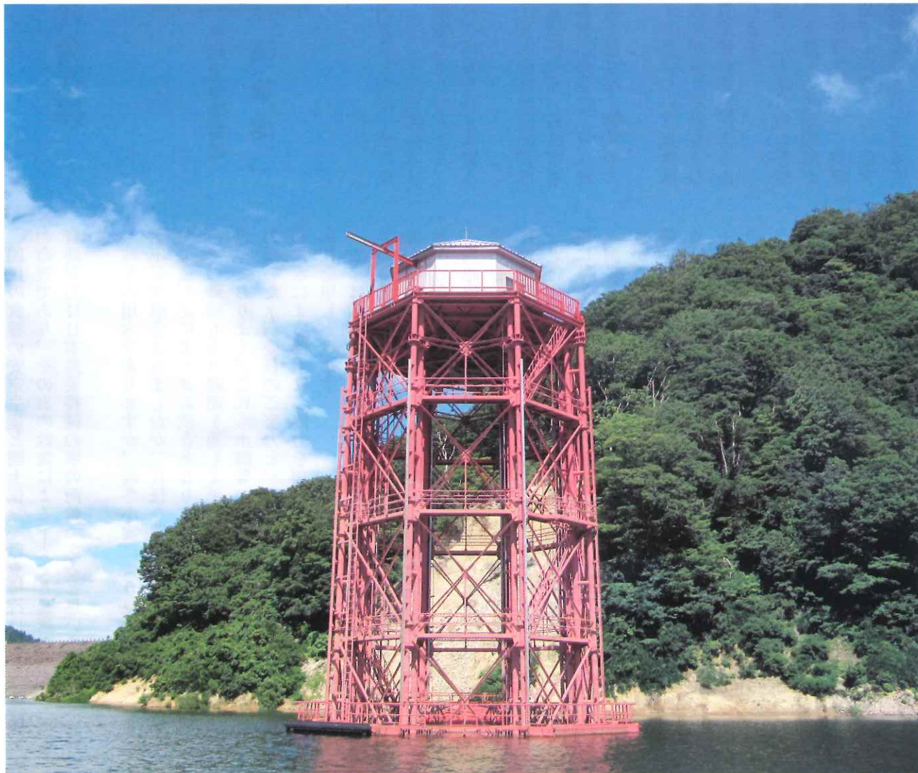
犬黒取水塔（白川ダム湖面から撮影）
