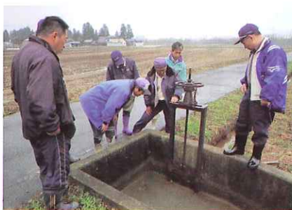
施設の機能診断
