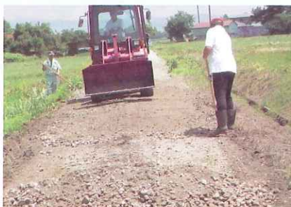
共同作業による敷砂利
