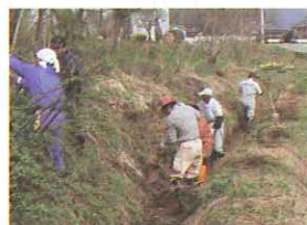
共同作業による水路土砂上げ
