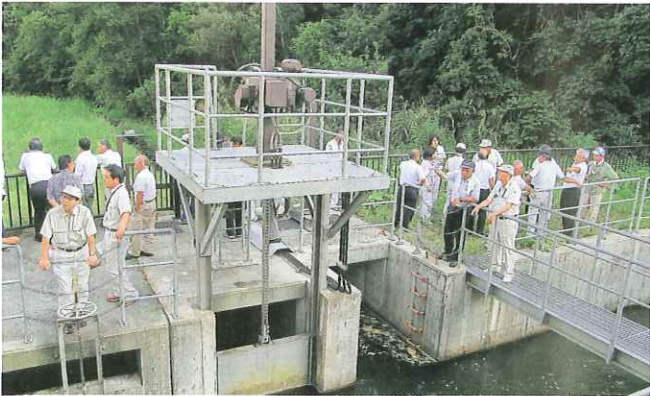
犬川上流分水工
