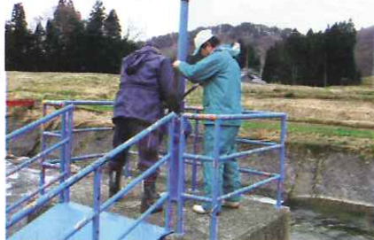
水門の保守管理
