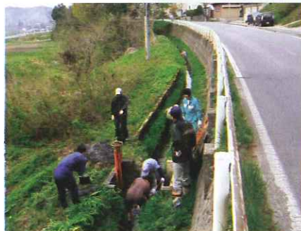
開水路の土砂上げ
