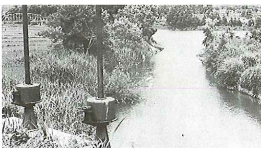
堰口及び取水口樋門
