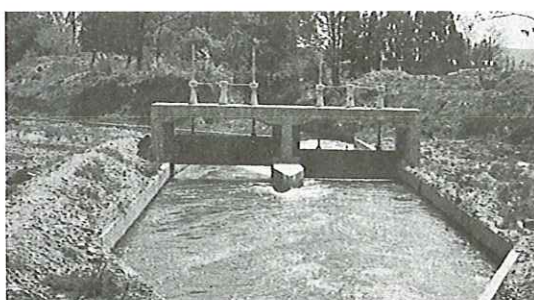
六ヶ村堰 長堀堰の分水口
