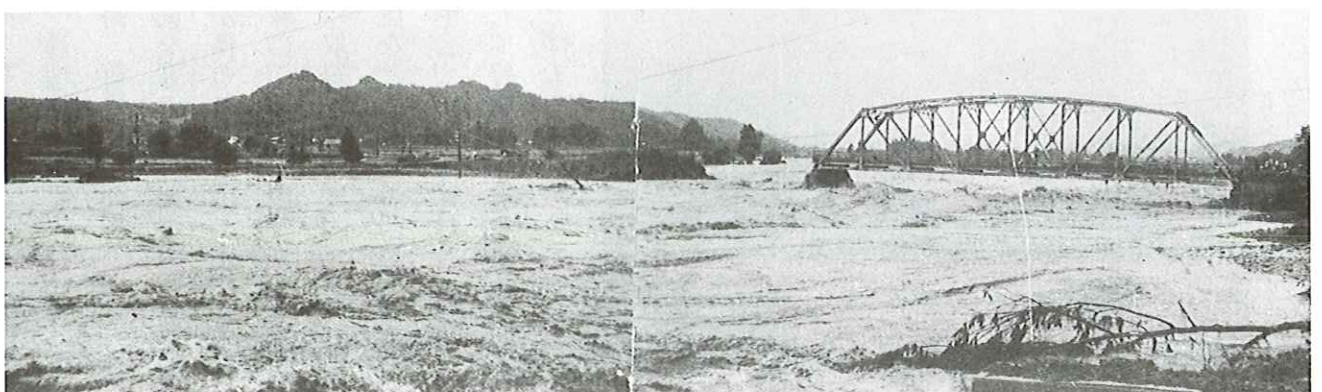
未曾有の大水害に見舞われ、孤立で濁流と闘う長瀬橋
