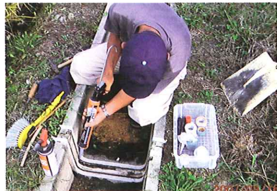
水路の目地補修技術の研修
