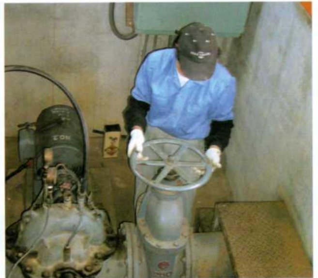
揚水機保守点検
