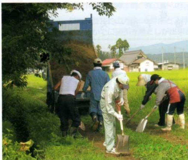
農道への敷砂利作業
