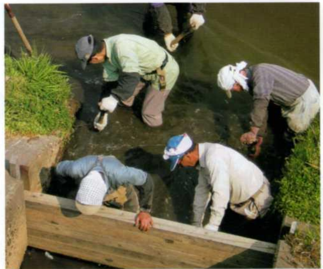
取水口土砂上げ作業
