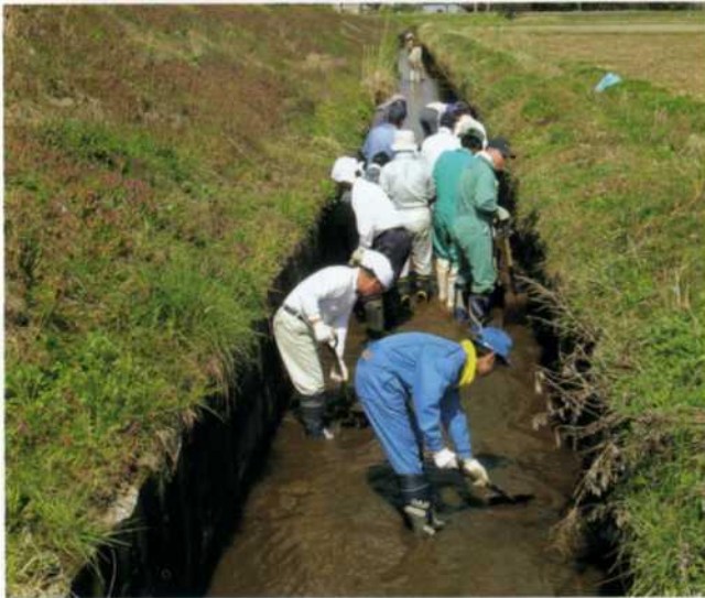
農業用水路の浚渫作業
