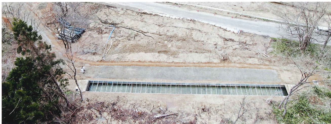
白川幹線水路仮復旧
