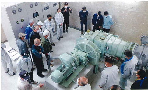
小水力発電所（小白川） ←
