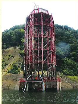
犬川黒川取水塔、水中ポンプ2台設置
